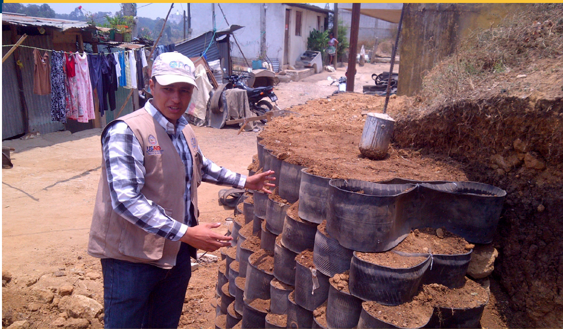
PCI Mixco-Guatemala. Muros de contención con llantas. Foto: J.P. Sarmiento
