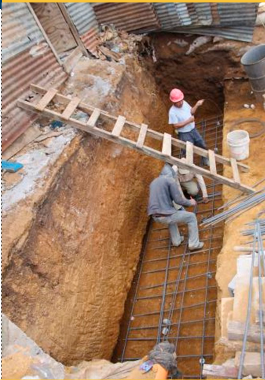
PCI Mixco-Guatemala. Construyendo muros de contención. Foto: PCI
